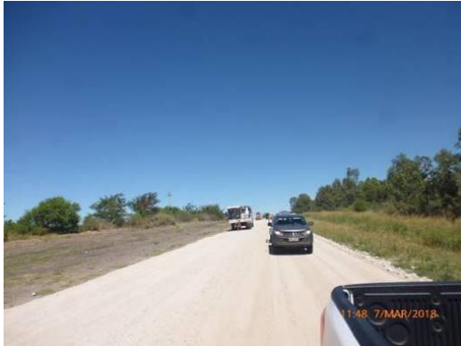
Ilustración 12 - Frente de obra: Terminación de la base
