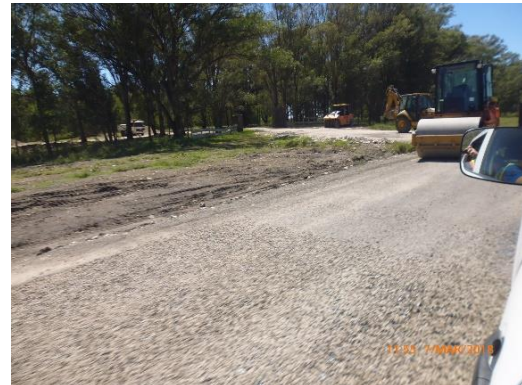
Ilustración 15 - Frente de obra: Agregados pétreos
