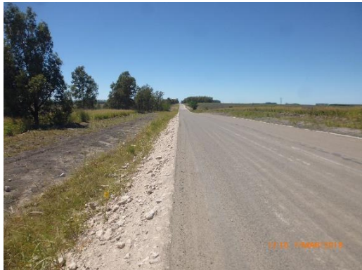
Ilustración 14 - Frente de obra: Imprimación con arena
