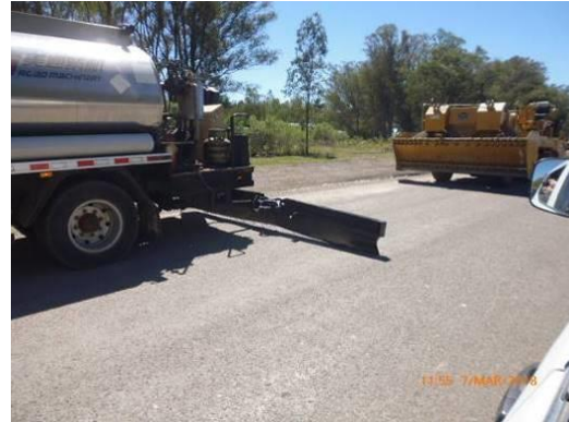
Ilustración 13 - Frente de obra: Riego de imprimación
