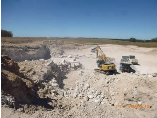
Ilustración 10 - Cantera de material granular.
