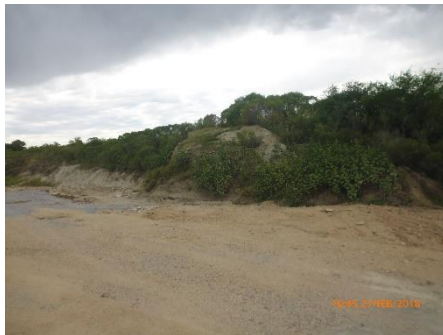
Ilustración 16 - Rampa de material eliminada. P05.
