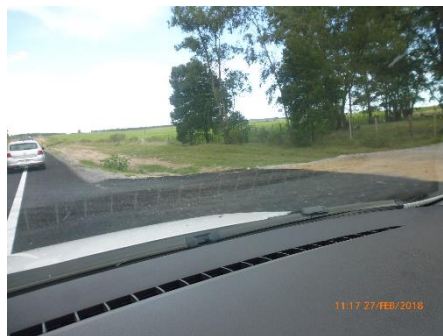
Ilustración 19 - Frente de obra. Alcantarillas para accesos a propiedades.
