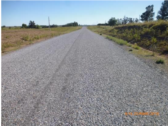
Ilustración 4 - Tramo entre Migués y el Obrador
