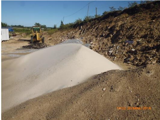
Ilustración 16 - Obrador: Acopio de áridos finos.
