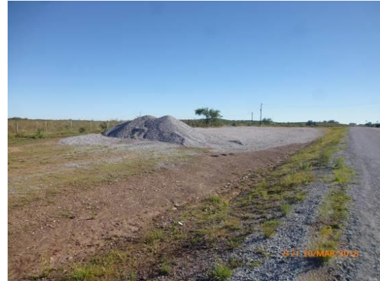
Ilustración 5 - Acopios en la faja para bacheos
