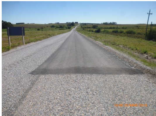
Ilustración 6 - Tramo con tratamiento de adherencia.
