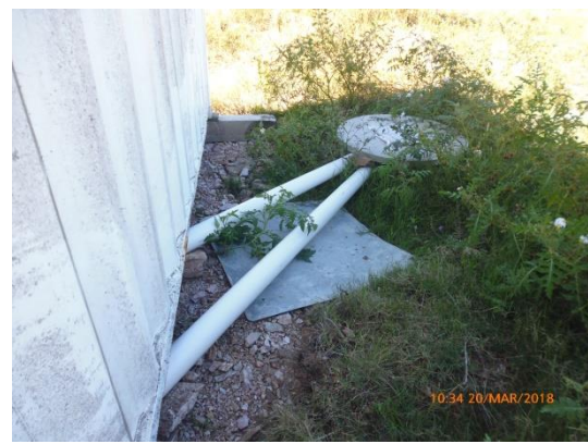
Ilustración 21 - Conexión de baños a depósito fijo
