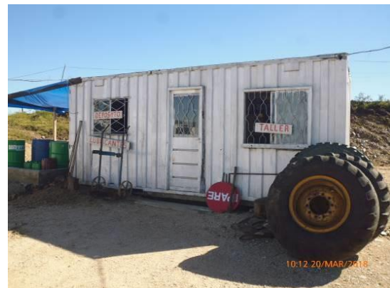
Ilustración 9 - Obrador: Taller y depósito
