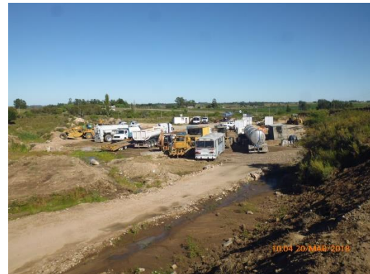
Ilustración 7 - Obrador: vista general
