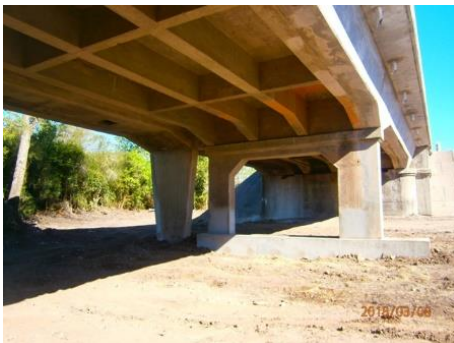
Ilustración 8 - Puente sobre A° Villasboas P04
