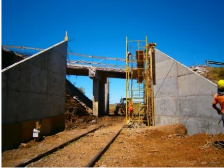
Ilustración 4 - muro de contención P01
