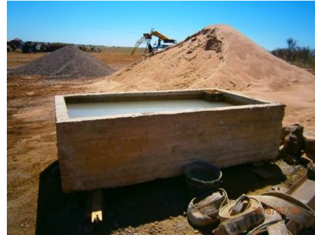
Ilustración 5 - pileta de lavado de herramientas usadas en el hormigonado P01
