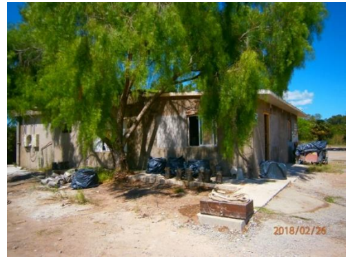
Ilustración 8 - vivienda utilizada como oficinas al momento de la obra. Actualmente en etapa de limpieza
