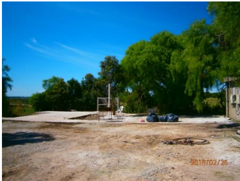
Ilustración 7- plataforma de hormigón (ex - comedor y parrillero). No se demuelen a pedido del dueño del padrón N° 1696
