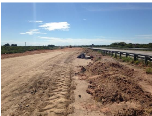
Ilustración 9 - accesos del puente, único frente de obra a cargo de la empresa Ramón C Álvarez
