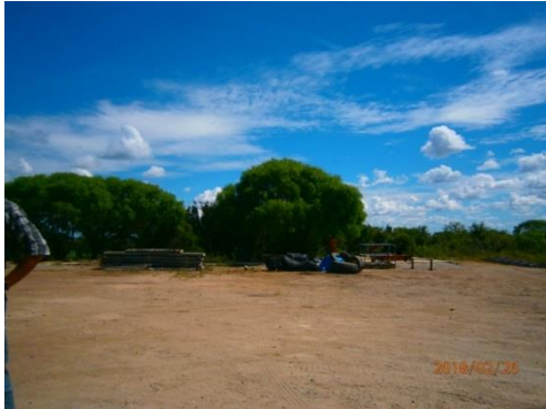
Ilustración 5 – padrón N° 1696 Obrador de Saceem. Actualmente en etapa de limpieza.
