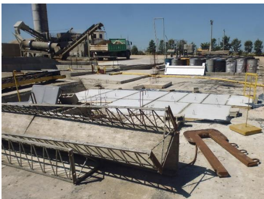
Ilustración 10 – Vista parcial del obrador
