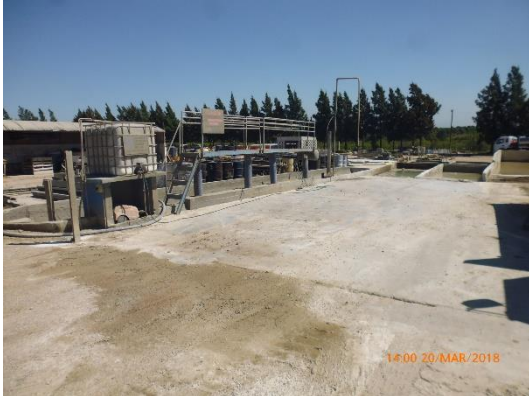
Ilustración 6 – Zona de lavado de maquinaria
