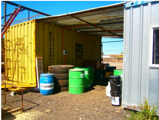
Ilustración 11 - depósito de combustible en etapa de construcción
