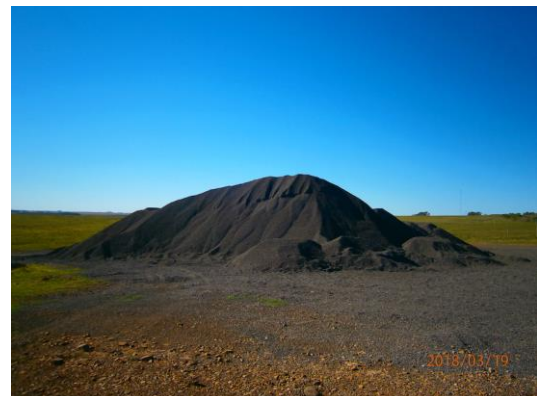
Ilustración 7 - acopio de material a la espera de ser trasladado al nuevo obrador.
