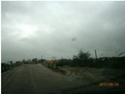
Ilustración 13 – Frente de obra
