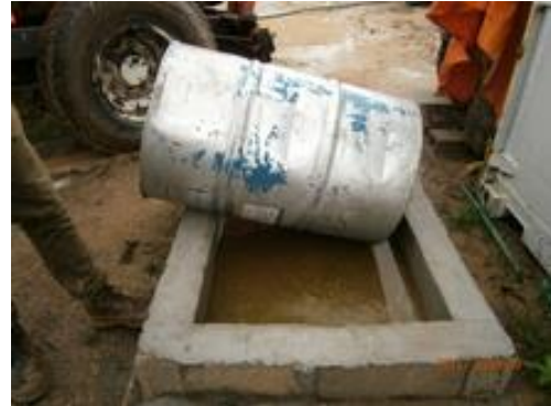
Ilustración 8 – Contenciones y solución para lavado de hormigones
