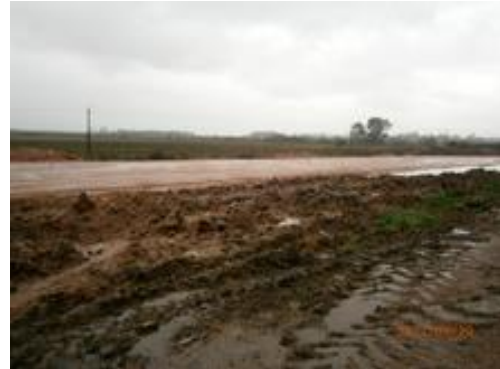
Ilustración 12 – Frente de obra
