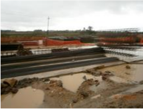
Ilustración 5 – Obrador, materiales de herrería.
