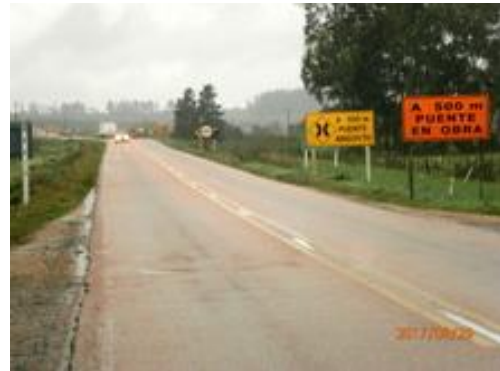
Ilustración 14 – Señalización en frente de obra
