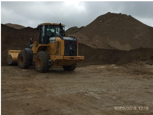
Ilustración 6 - Obrador. Zona de cantera.
