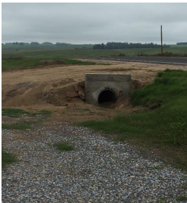
Ilustración 8 – Tramo de obra, alcantarilla para entrada particular construida.
