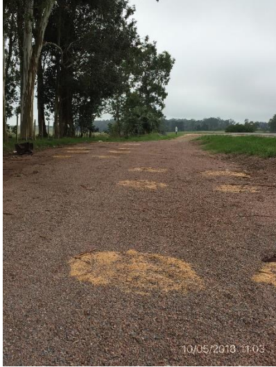
Ilustración 4 – Zona de acopio en faja, progresiva 216K000
