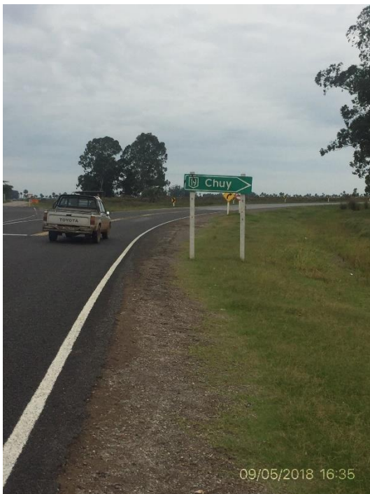
Ilustración 6 – Fin del tramo Ruta 15 progresiva 1650K000, empalme con Ruta 19.
