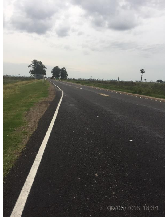
Ilustración 5 – Fin del tramo Ruta 15 progresiva 1650K000, empalme con Ruta 19
