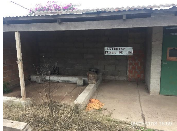
Ilustración 7 – Obrador desmontado, localidad San Luis al Medio
