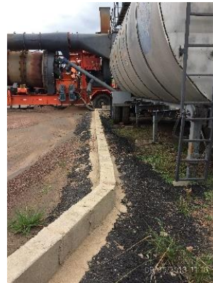
Ilustración 11 – Obrador. Planta de asfalto con envallado.
