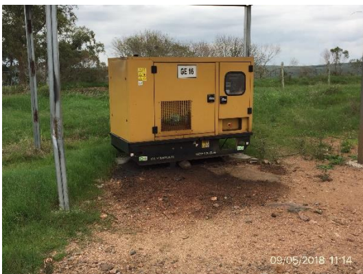
Ilustración 14 – Grupo electrógeno
