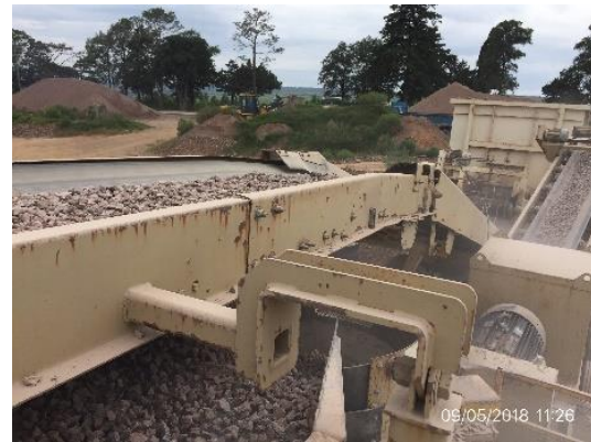
Ilustración 13 – Obrador. Planta de trituración.
