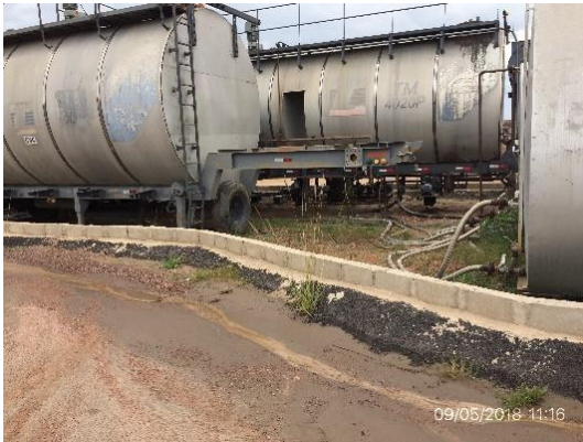
Ilustración 10 - Obrador. Planta de asfalto.
