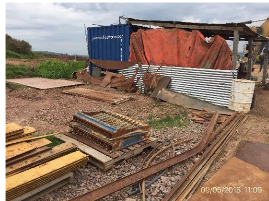
Ilustración 7 - Obrador. Depósito de hierro.
