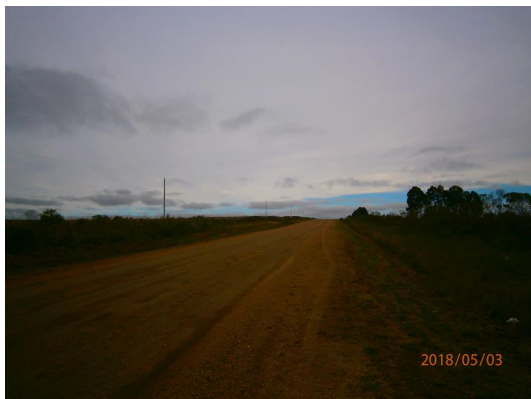
Ilustración 6 - Tramo de obra.
