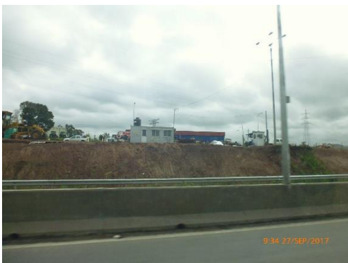
Ilustración 15 - P03. Taludes sin cobertura vegetal.
