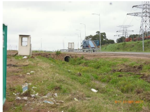
Ilustración 8 - P03. Alcantarilla a remover.
