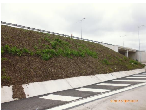
Ilustración 9 - Taludes conformados.
