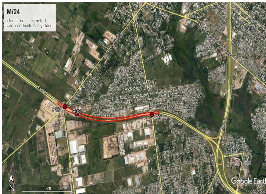
Ilustración 3 - Tramo de obra. Intercambiadores sobre Cno. Cibils (P01) y Cno. Tomkinson (P02) sobre Ruta 1. Obrador de Molinsur (P03).
