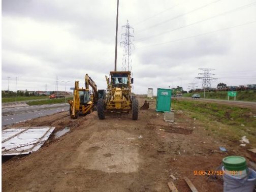
Ilustración 5 - P03. Obrador. Maquinaria y baño químico.
