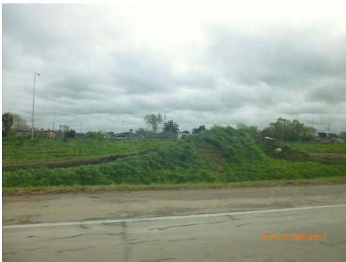
Ilustración 13 - Acopio de cobertura vegetal.
