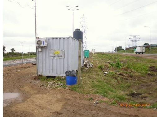
Ilustración 6 - P03. Obrador. Contenedor oficina.
