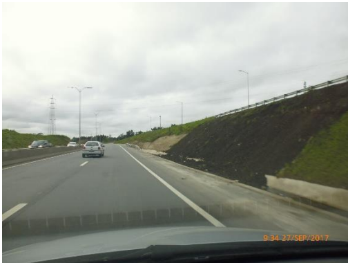
Ilustración 11 - Taludes con cobertura de tierra y taludes empastados.
