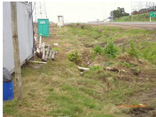
Ilustración 14 - P03. Oficina conectada a un depósito fijo impermeable a retirar.
