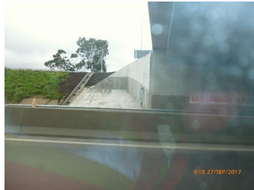
Ilustración 12 - Tobogán para descenso de pluviales en pasos elevados.
