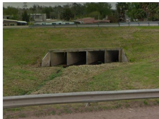
Ilustración 16 – Alcantarilla de hormigón de cuatro bocas, arroyo Bellaca.
