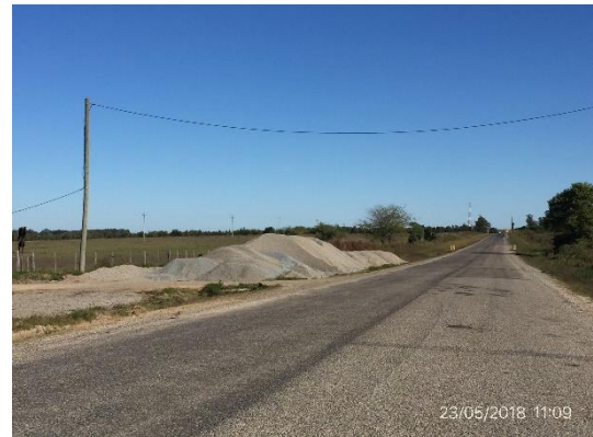
Ilustración 7 – Acopio provisorio, progresiva 96K000.
