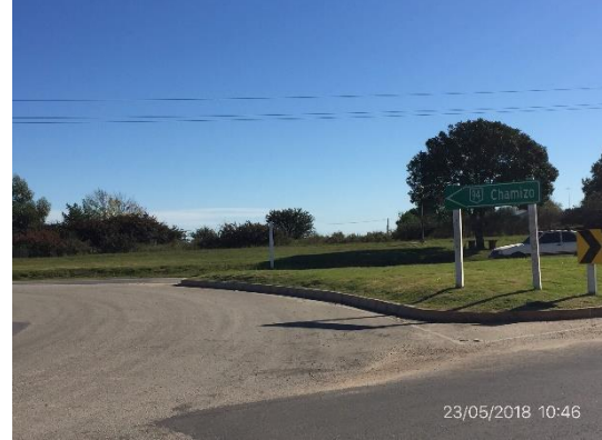
Ilustración 5 – Fin del tramo, progresiva 104K600, Fray Marcos.
