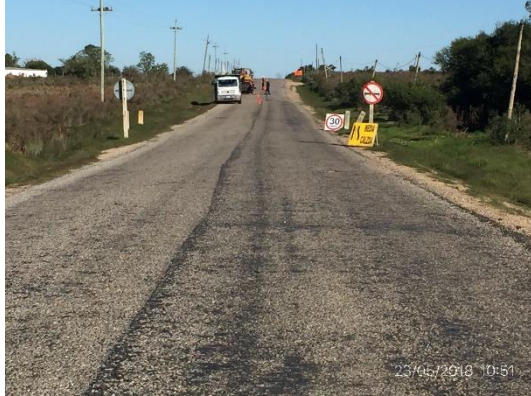
Ilustración 4 – Trabajos en frente de obra, progresiva 94K200
