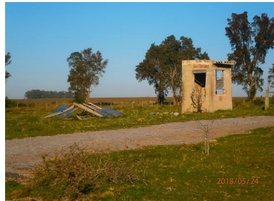
Ilustración 7 - Cantera. Casilla de seguridad.
