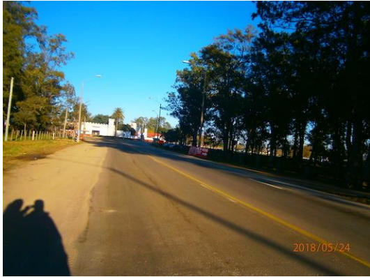
Ilustración 4 - Tramo de obra. Ciudad de Trinidad.
