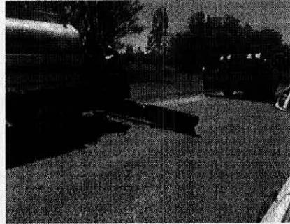
Ilustración 13 - Frente de obra: Riego de imprimación
