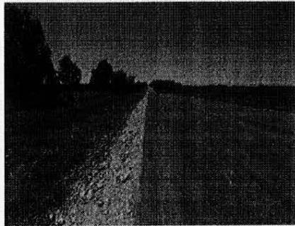
Ilustración 14 - Frente de obra: Imprimación con arena
