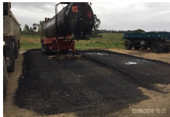
Ilustración 9 - Obrador. Pavimento y envallado impermeable bajo depósito de emulsión.
