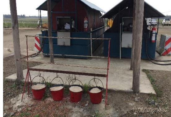
Ilustración 5 - Obrador. Depósitos de combustible.
