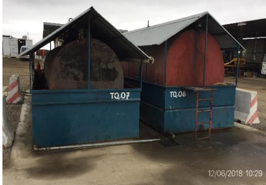
Ilustración 4 - Obrador. Depósitos de combustible.
