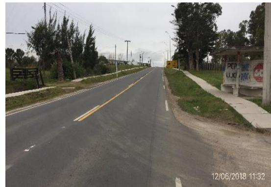
Ilustración 13 - Obrador. Tramo recuperado en Ruta 74 y sendas peatonales.
