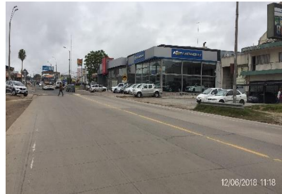
Ilustración 11 – Tramo de obra construido en Ruta 8.
