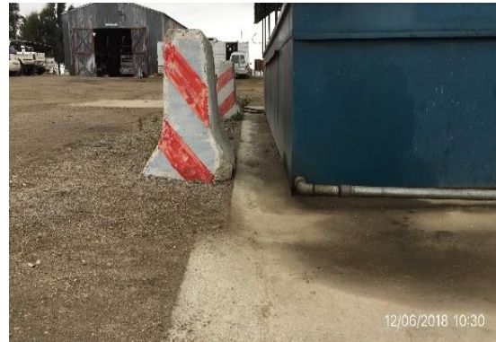
Ilustración 7 - Obrador. Pavimento impermeable y envallado en depósito de combustibles.
