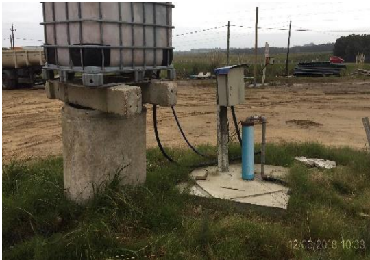
Ilustración 10 - Perforación para uso de agua subterránea.
