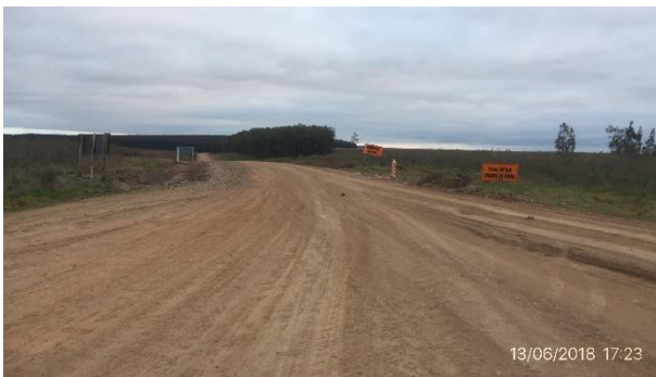
Ilustración 4 - Frente de obra – Fin de tramo progresiva 123K600 empalme con Ruta 4
