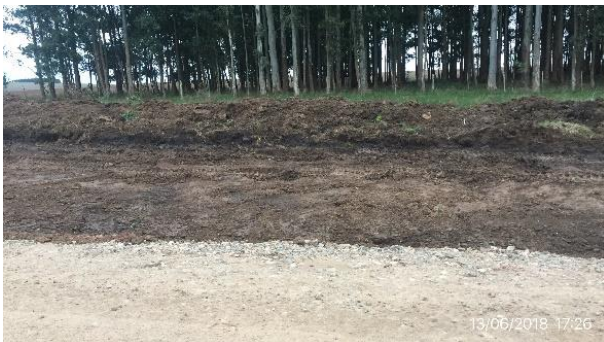
Ilustración 6 - Frente de obra – acopio vegetal ordenado
