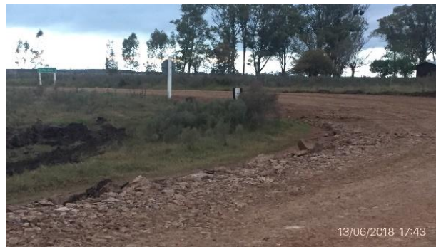
Ilustración 5 - Frente de obra – Inicio de tramo progresiva 115K000 Ruta 20, entrada a Pueblo Greco
