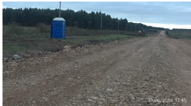
Ilustración 7 - Frente de obra: sub - base granular terminada
