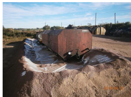
Ilustración 9 - cisterna de emulsión asfáltica.
