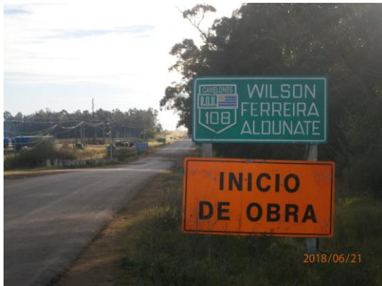
Ilustración 4 - frente de obra.
