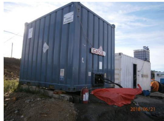
Ilustración 7 - depósito de combustible.
