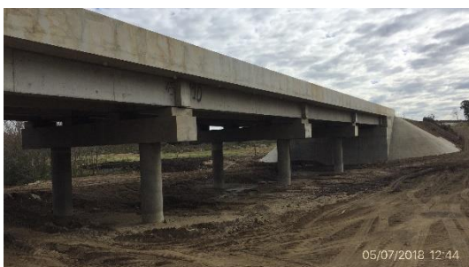
Ilustración 14 – Frente de obras,
