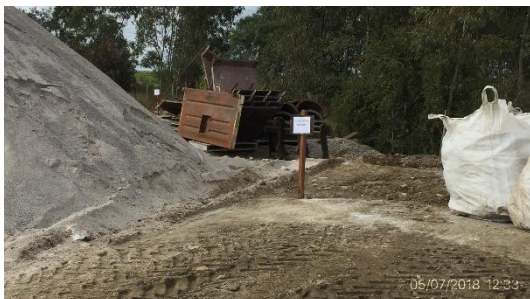
Ilustración 10 – Obrador, acopio de materiales granulares
