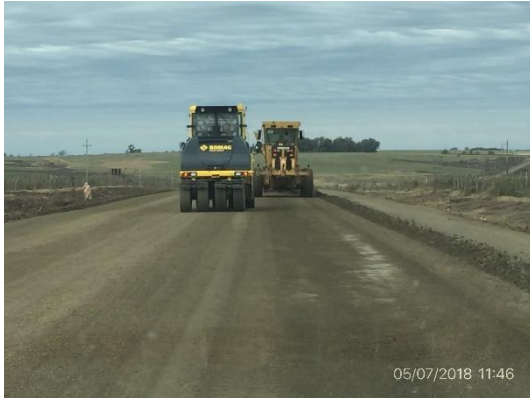
Ilustración 4 – Frente de obras.
