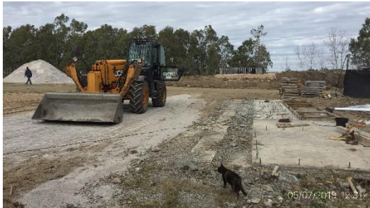
Ilustración 8 – Obrador, planta de prefabricados desmontada
