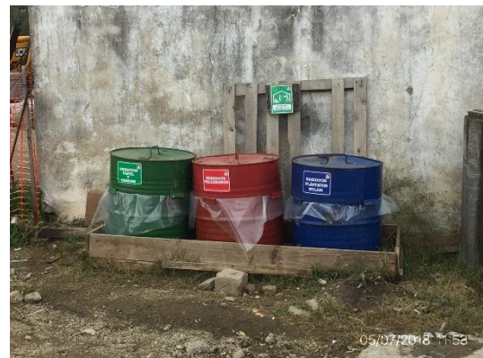
Ilustración 7 – Obrador. Acopio de residuos con segregación de canales
