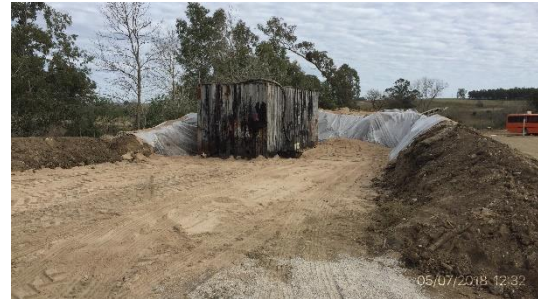
Ilustración 9 – Obrador, depósito de productos asfálticos con envallado perimetral
