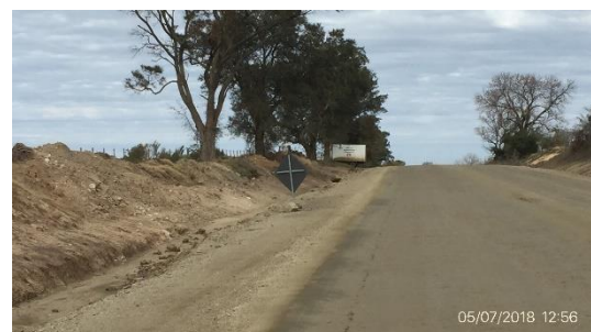
Ilustración 15 – Frente de obras
