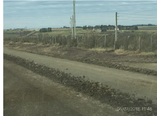
Ilustración 5 – Frente de obras.
