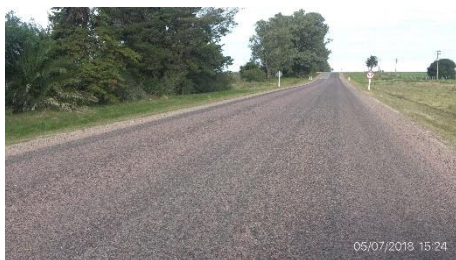
Ilustración 8 – Ruta 54, tramo rehabilitado en todo el ancho de ruta
