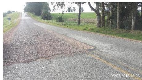
Ilustración 9 – Ruta 54, tramo rehabilitado en media calzada de ruta
