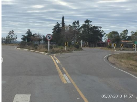
Ilustración 4 – P02 – Fin de tramo en Ruta 54
