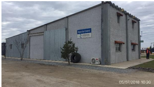
Ilustración 4 - Obrador. Vista general
