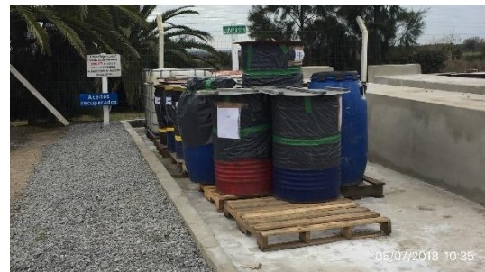
Ilustración 9 – Acopio de lubricantes usados con piso y envallados estancos
