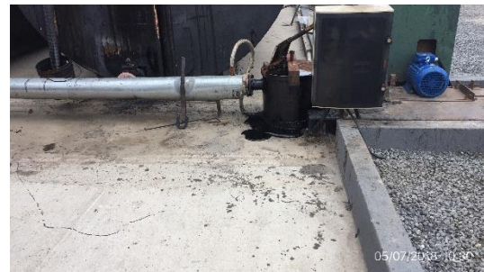
Ilustración 7 – planta de asfalto con envallados.
