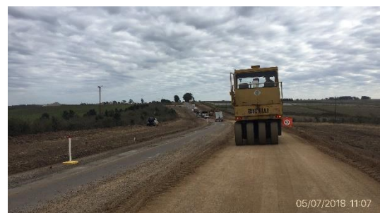
Ilustración 11 – Trabajos en fente de obras progresiva 130K000
