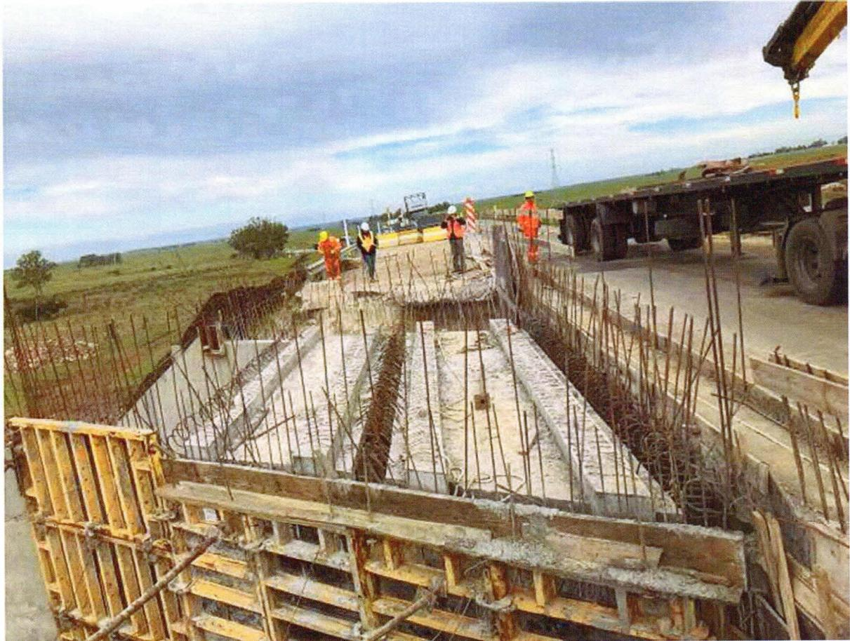
**Imagen 8 – Vista tareas encofrado y armado de hierro**
