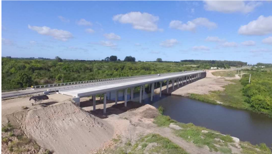
Imagen 5: Vista del frente de obra
