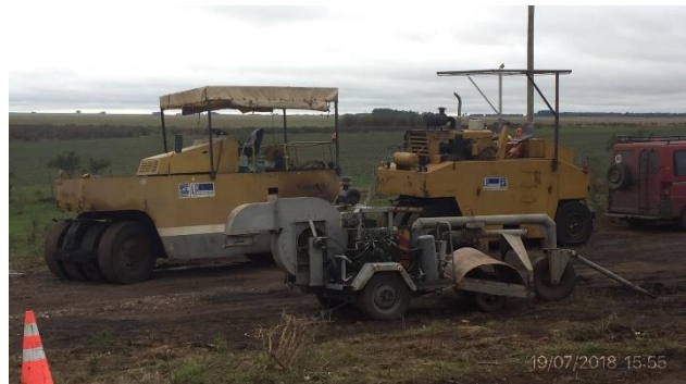
Ilustración 11 - frente de obras
