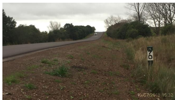
Ilustración 5 – inicio de tramo, Ruta 26 progresiva 70K000
