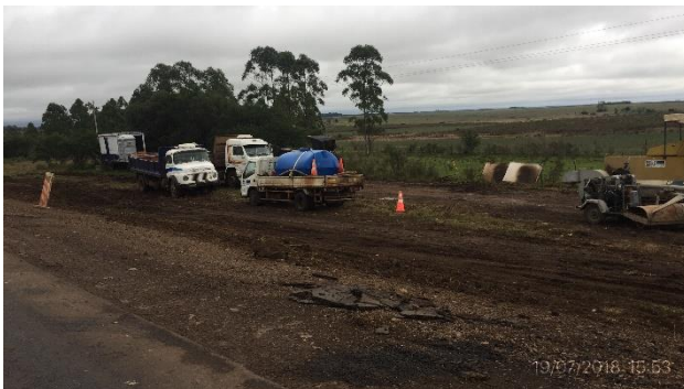
Ilustración 10 – frente de obras
