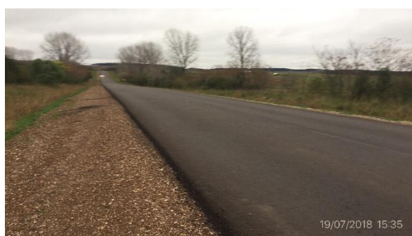
Ilustración 6 – Rehabilitación de pavimento Ruta 26
