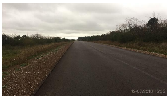
Ilustración 7 – Rehabilitación de pavimento Ruta 26
