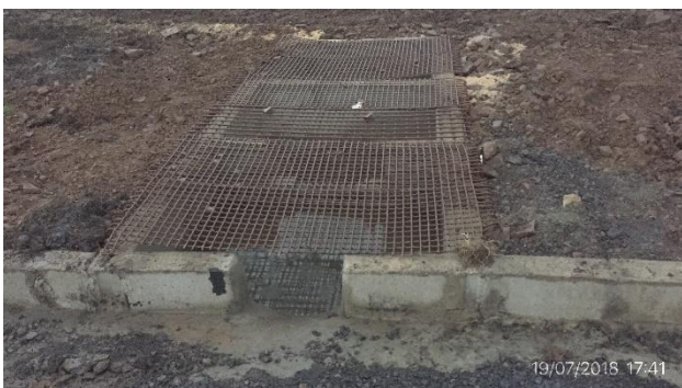
Ilustración 20 - Obrador. Zona de lavado de maquinaria, pileta de decantación.
