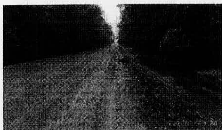
Ilustración 4 – Tramo de obra terminado
