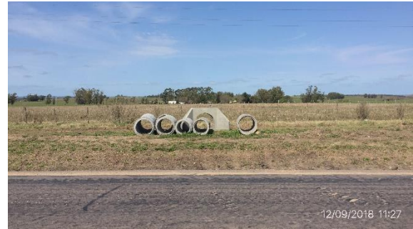
Ilustración 13 - acopio en espera de piezas en hormigón para construcción de alcantarillas
