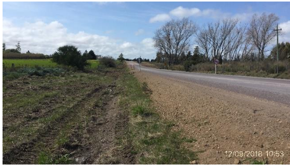
Ilustración 14 – tramo de obras con faja acondicionada
