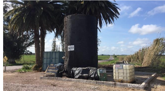
Ilustración 5 - P03 Obrador – acopio de emulsión con envallado perimetral
