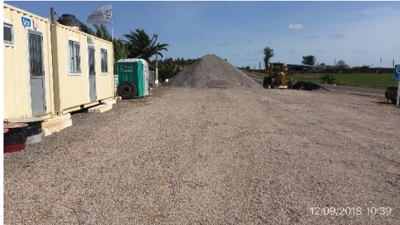
Ilustración 4 – P03 Obrador – Acopio de áridos
