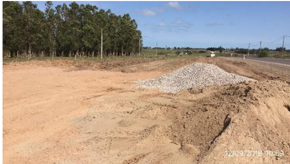
Ilustración 12 - Acopio en faja progresiva 339K000
