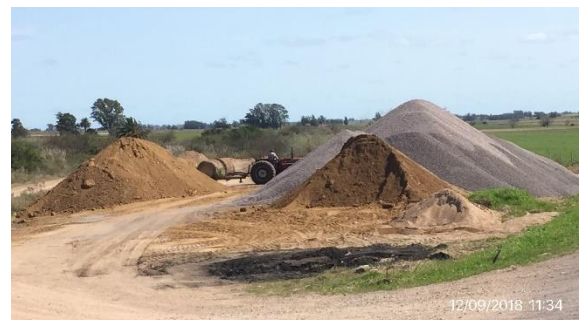
Ilustración 11 – Acopio en faja - 332K000
