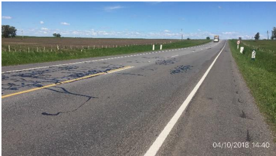
Ilustración 6 – Obras de sellado en el tramo.
