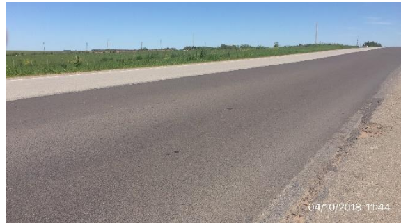
Ilustración 7 – Obras de bacheo en el tramo.
