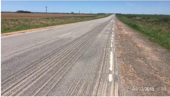
Ilustración 4 – Obras de fresado.
