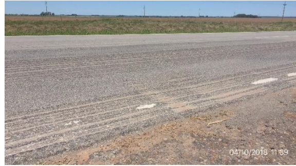
Ilustración 5 – Obras de fresado.
