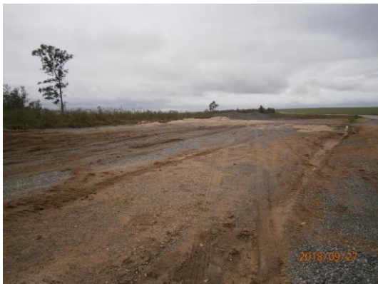
Ilustración 7 - zona de acopio.
