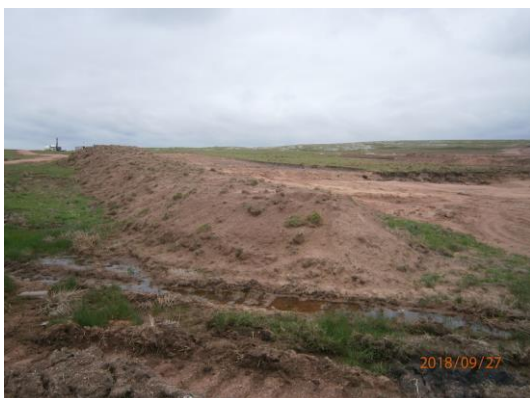
Ilustración 9 - acopio de suelo vegetal.
