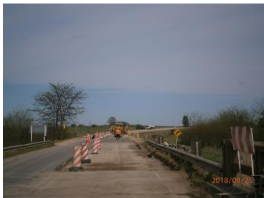
Ilustración 19 - frente de obra.
