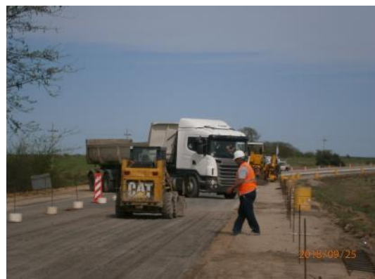
Ilustración 15 - frente de obra.
