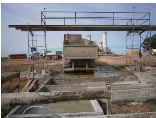
Ilustración 6 - piletas de decantación.
