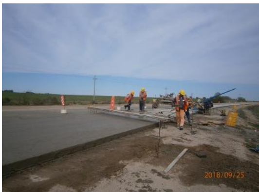
Ilustración 18 - frente de obra.
