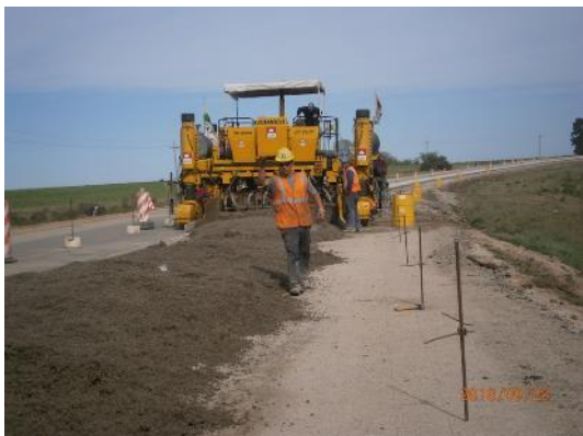
Ilustración 16 - frente de obra.
