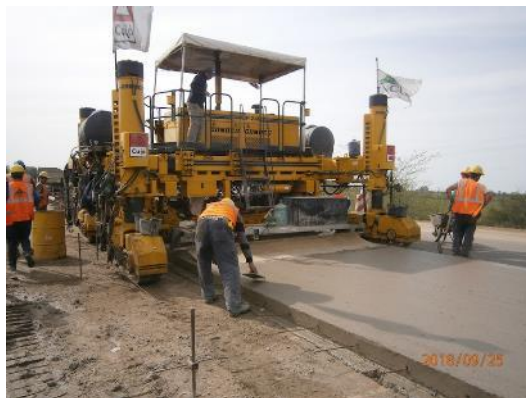
Ilustración 17 - frente de obra.
