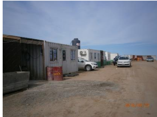
Ilustración 11 - oficinas en el obrador.
