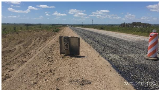
Ilustración 6 – Frente de obras, reconstitución de banquinas en Ruta 12
