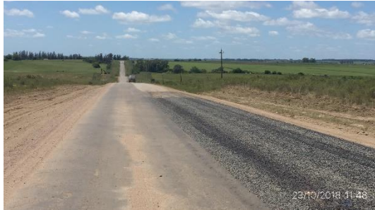
Ilustración 4 – Frente de obras: bacheo en Ruta 12
