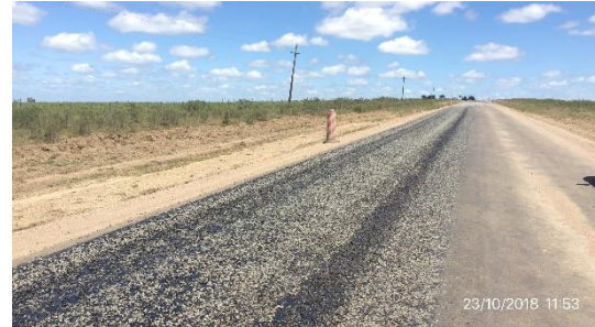
Ilustración 5 – Frente de obras: bacheo en Ruta 12.
