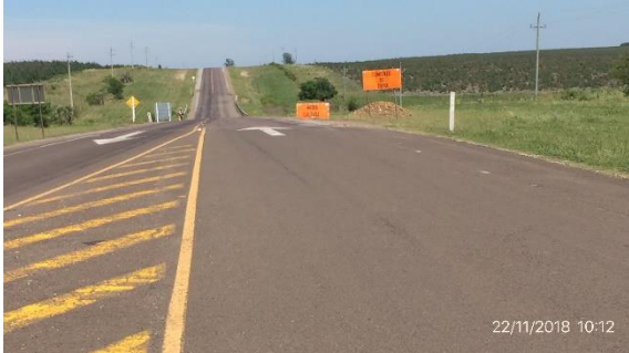
Ilustración 4 – Inicio de tramo, empalme de Rutas 90 y 25
