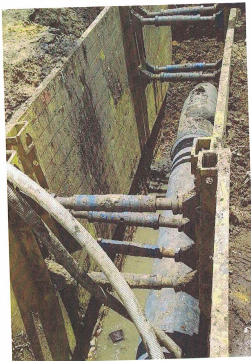
Imagen 7 y 8 – Colocación de tubería
