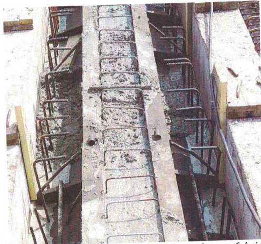
Imagen 2, 3 y 4 – Losetas pretensadas prefabricadas
