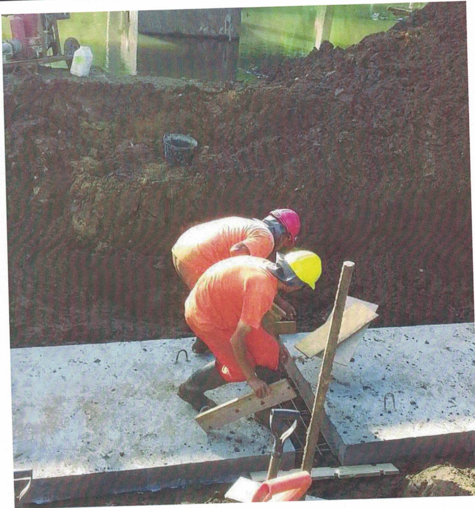
Imagen 5 y 6 – Losetas prefabricadas para protección de tubería
