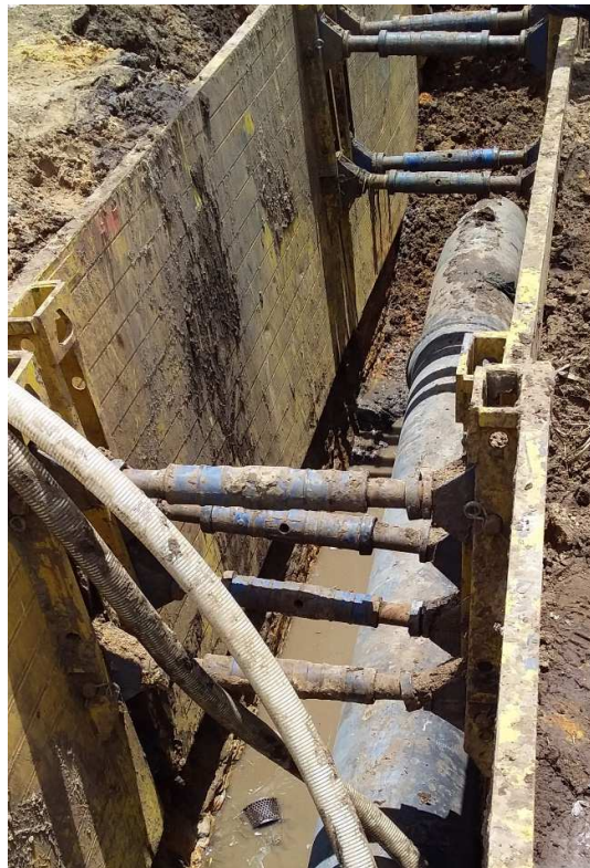
Imagen 7 y 8 – Colocación de tubería
