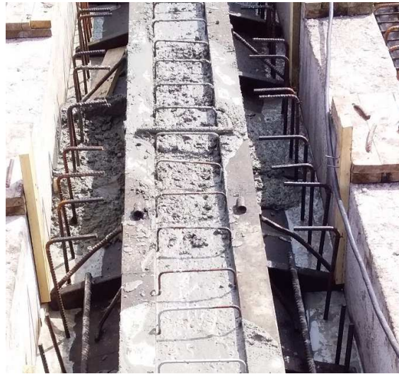
Imagen 2, 3 y 4 – Losetas pretensadas prefabricadas
