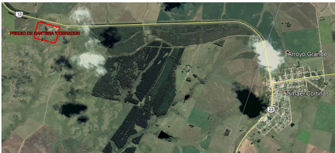
Vista de la cantera y área de obrador
