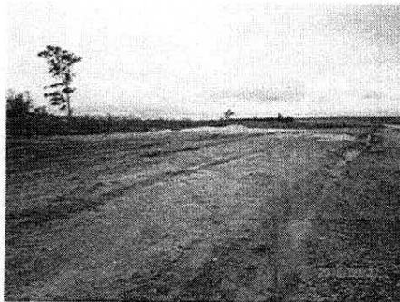
Ilustración 7 - zona de acopio.
