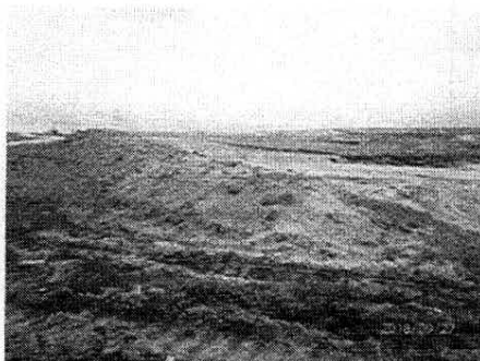
Ilustración 9 - acopio de suelo vegetal.
