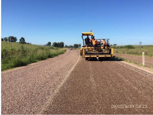
Ilustración 10 - Frente de obra, Ruta 8 progresiva 419K000.
