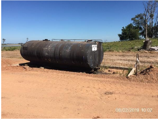
Ilustración 4 – Obrador. Depósito impermeable con contención perimetral
