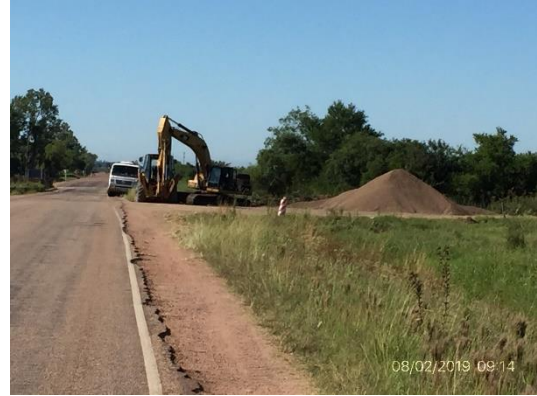
Ilustración 11 – Acopio granular en faja pública de Ruta 8, con autorización de DDO.
