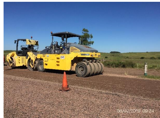
Ilustración 9 – Frente de obra, Ruta 8 progresiva 419K000.
