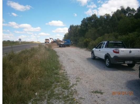
Ilustración 5 – Faja publica Trabajos Vialidad.
