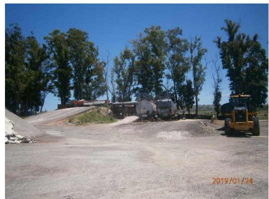
Ilustración 10 - Maquinas y acopios en obrador
