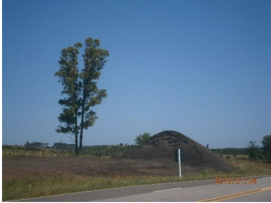
Ilustración 5 - Acopio de material excedente del fresado
