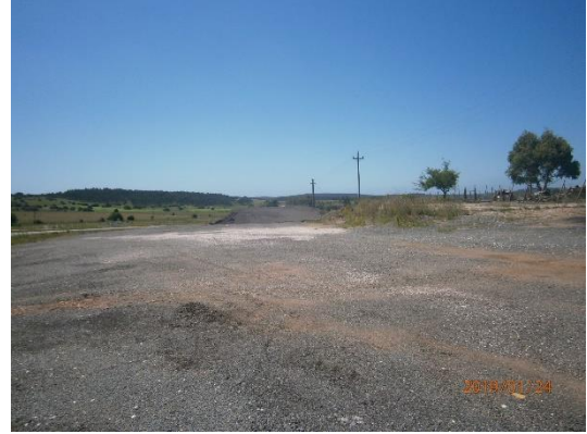
Ilustración 6 - Acopio material fresado
