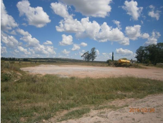
Ilustración 4 – Acopio de material en faja y tanque de agua.
