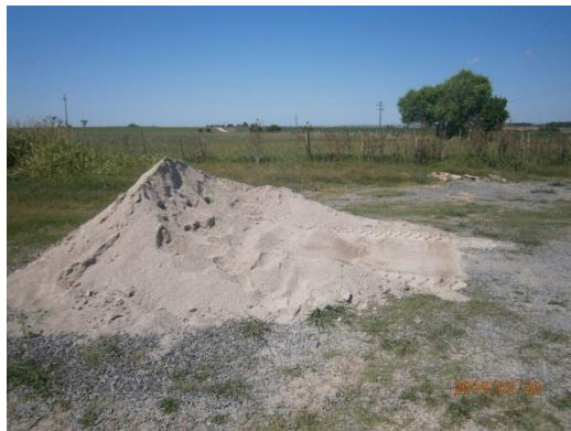
Ilustración 6 – Faja publica previamente compactada, acopio.
