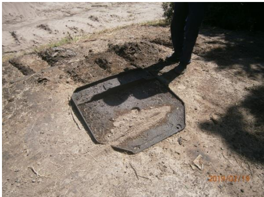
Ilustración 6 - Evidencia de trabajo con hidrocarburos en piso sin impermeabilizar, NC 1.
