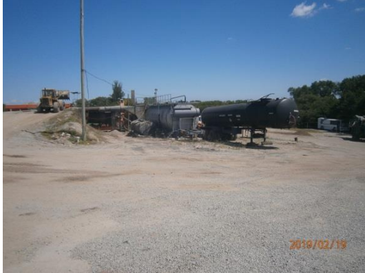
Ilustración 12 - Vista general de planta asfáltica
