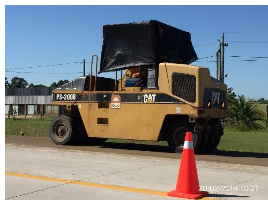
Ilustración 13 - frente de obra.
