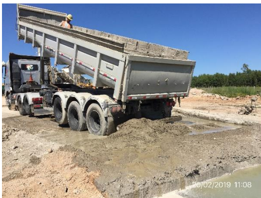
Ilustración 6 - Obrador. Piletas de decantación.
