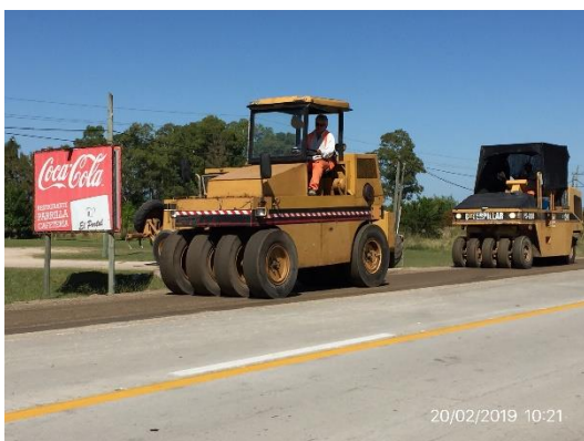
Ilustración 12 - frente de obra.
