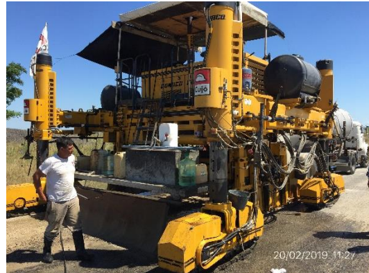
Ilustración 11 – Frente de obra.
