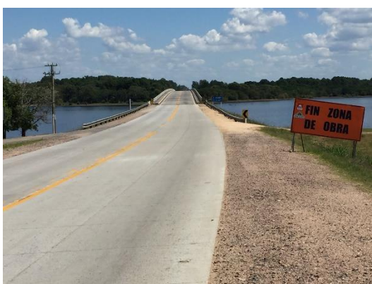
Ilustración 14 – final del tramo, progresiva 243K000
