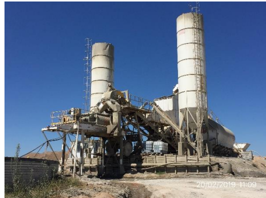
Ilustración 5 - Obrador. Planta de hormigón.
