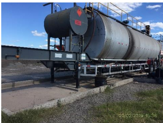
Ilustración 14 – Obrador. Planta de asfalto con envallado perimetral
