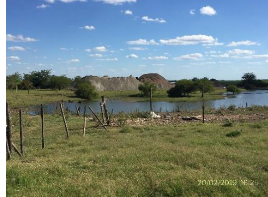
Ilustración 11 – Obrador, acopios de piedra de cantera Ruta 4 desafectada.
