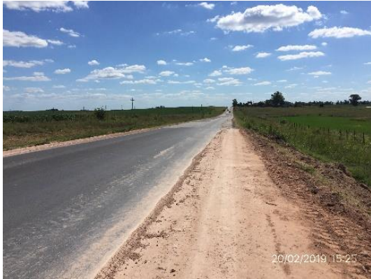
Ilustración 4 – Tramo de obra bacheado
