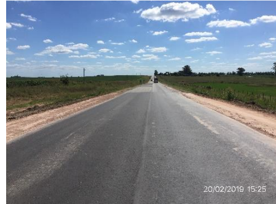
Ilustración 5 – Tramo de obra bacheado.
