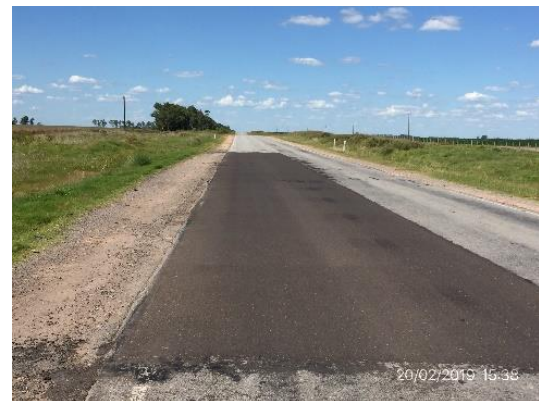
Ilustración 7 – recuperación realizada en ambas fajas.
