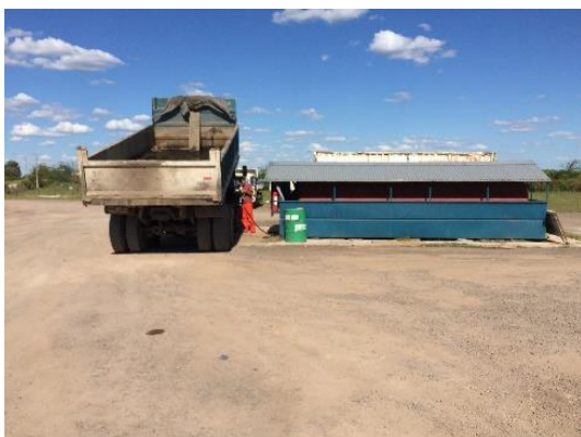
Ilustración 8 – Obrador, tanque de combustible techado con envallado
