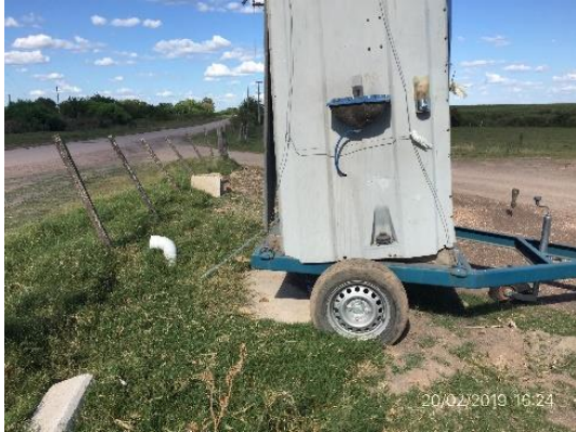
Ilustración 10 – Obrador, fosa impermeable de baños.
