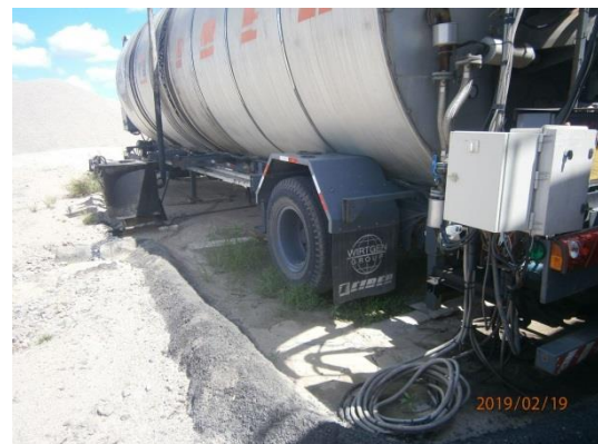
Ilustración 9 – Deposito de materiales asfálticos y muro de contención
