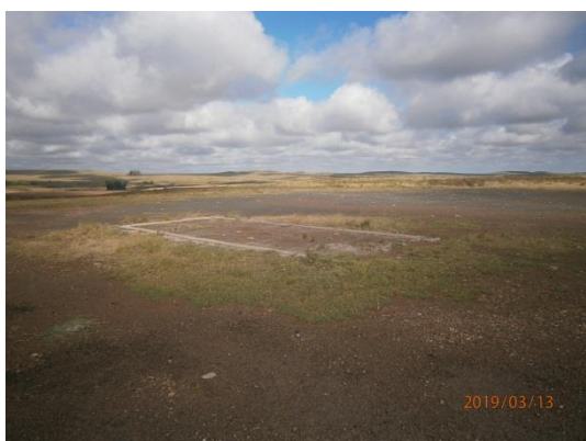
Ilustración 8 – Sector de lavado de maquinaria acondicionado
