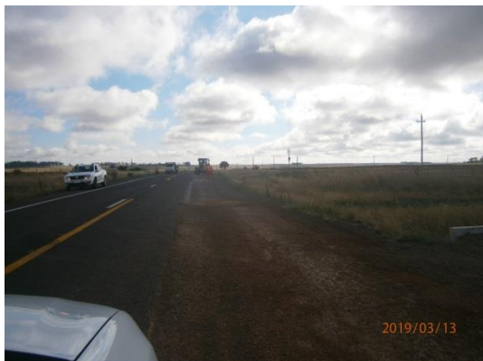
Ilustración 4 – Tramo de obra en reparación
