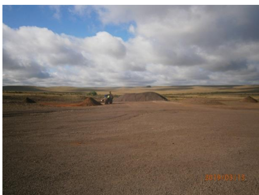
Ilustración 6 – Transporte y acopio de material granular
