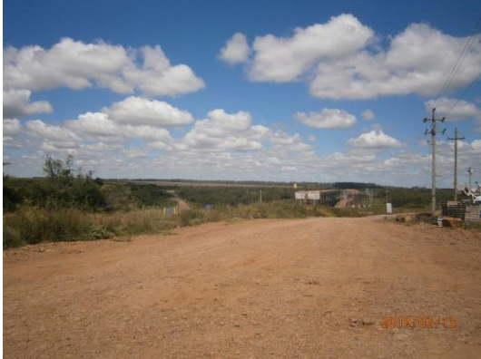
Ilustración 5 – Puente sobre el A° Cuaró desde el Obrador Principal
