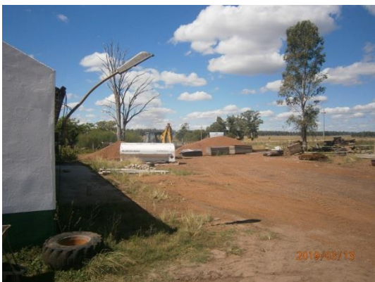
Ilustración 15 – Obrador de CUJÓ-INCOCI propiedad de vialidad
