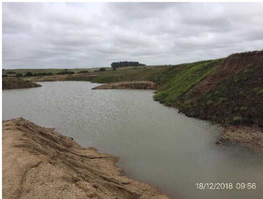
Ilustración 12 – Remediación realizada en cantera de tosca.
