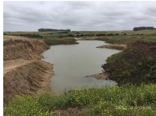
Ilustración 13 – Remediación realizada en cantera de tosca
